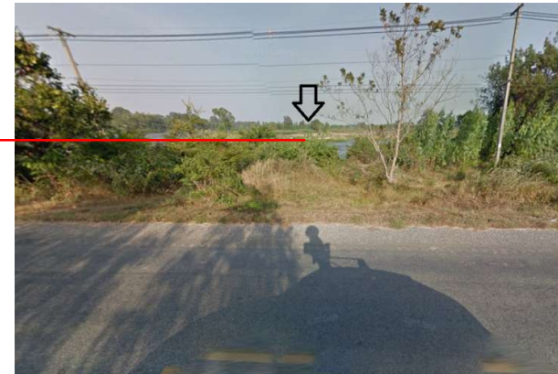
จุดที่ 1 หมู่ที่ 1 พื้นที่เสี่ยงภัย น้ำท่วม
